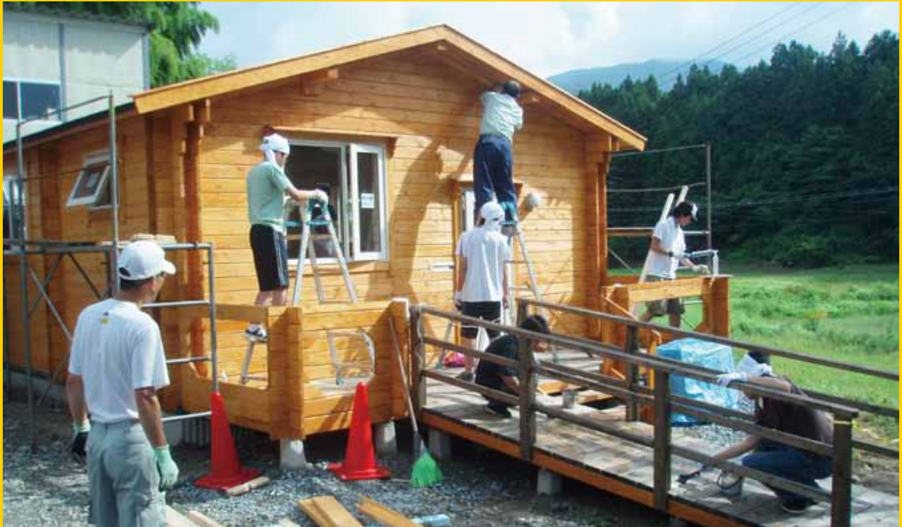
※2012年仮設図書館建設ボランティアの様子
